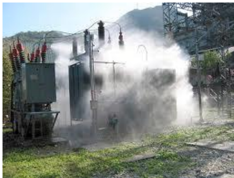
4.6 pav. Gaisro gesinimo sistemos vandens rūku veikimas
