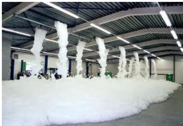
4.3 pav. Automatinės putų gesinimo sistemos veikimas
