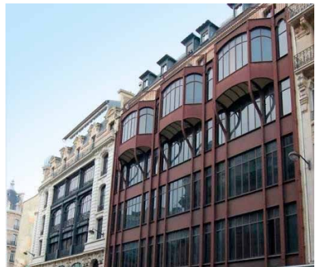
4 pav. Pastatas rue Reaumur Nr. 124 Paryžiuje (1905 m.). Šio pramonės gaminių dizaino priemonėmis (plieno konstrukcijų) dekoruotas pastatas. Architektas dizaineris Georgesas Chedanne (autorius nuotrauka)
