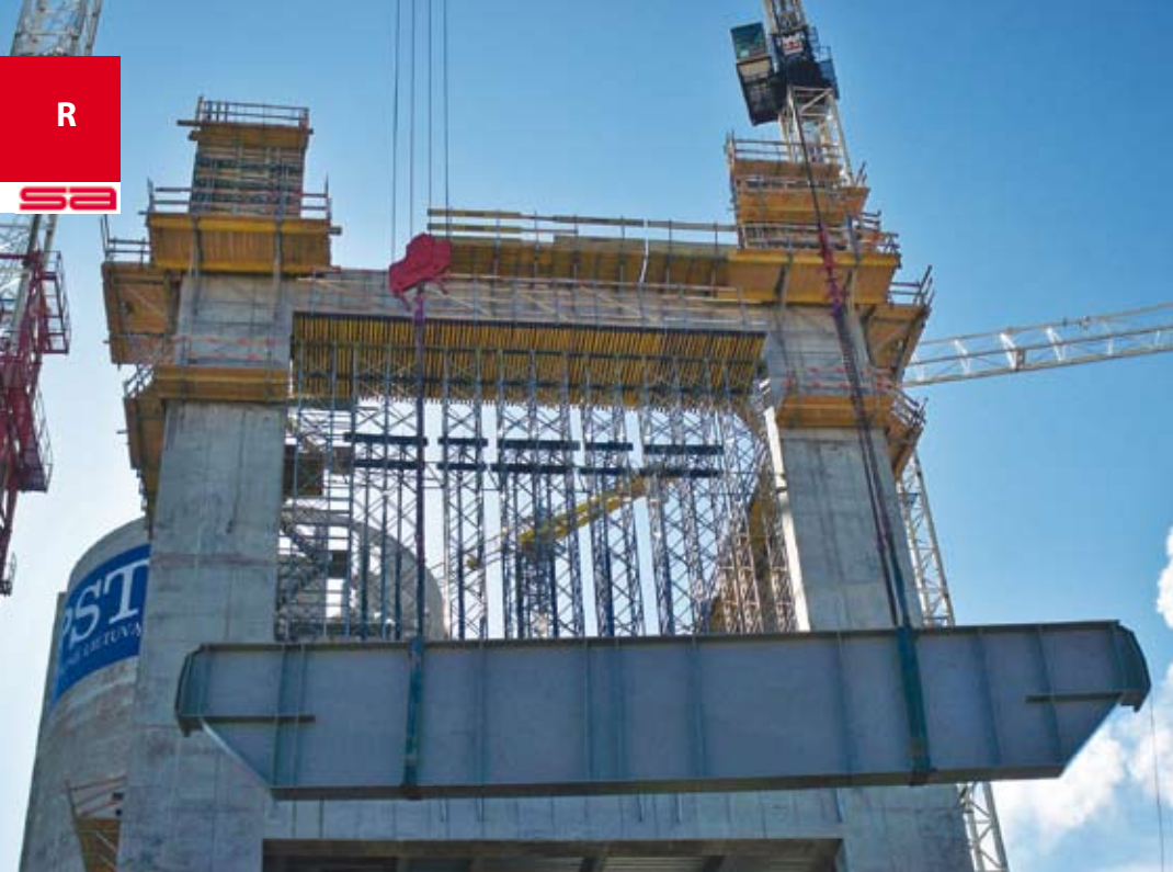
Dviem bokštiniais kranais montuojama įspūdingo dydžio metalinė perdangos sija sveria 33,59 t. AB Panevėžio statybos tresto nuotr.
