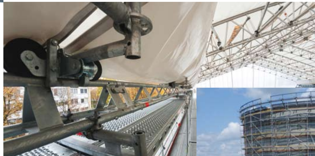
Laikinis stogas sumontuotas ant specialių bėgių. Užbaigus vieną darbų etapą stogą galima pastumti į kitą vietą.
