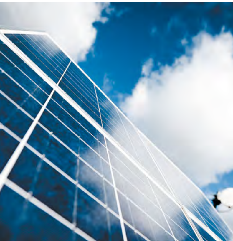
Saulės elementai ant VGTU stogo
