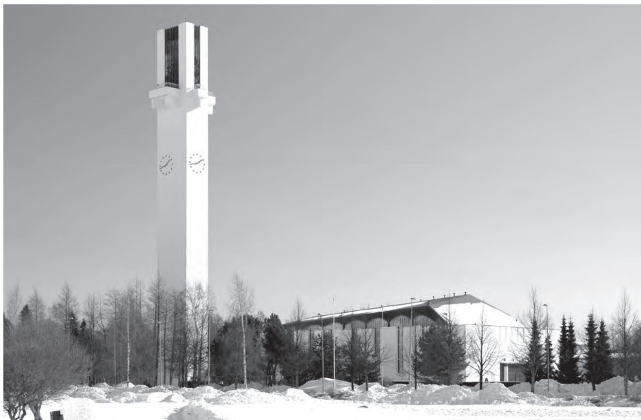
Seinājoki mieste, turinčiame tik 50 tūkst. gyventojų, akį džiugina garsaus architekto Alvaro Aalto projektuotas pastatų ansamblis. Nuotraukoje – architektūros meistro projektuota bažnyčia
